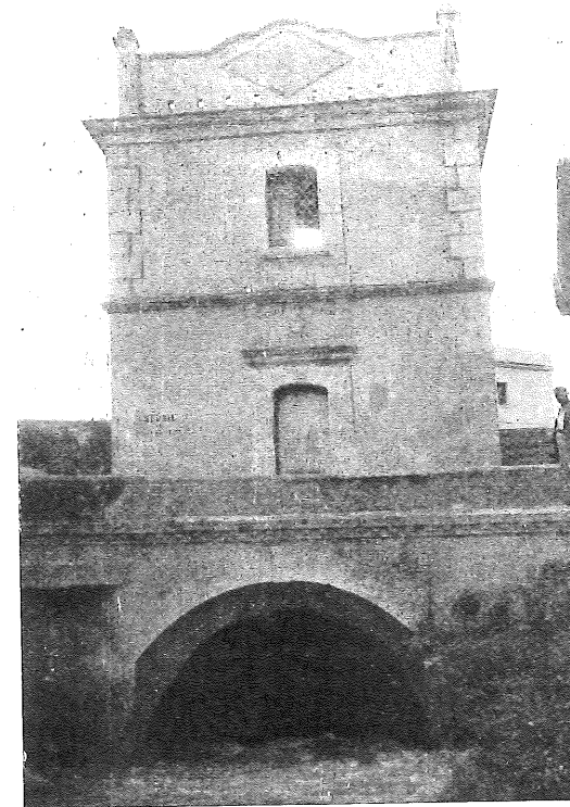
Compuerta de la Acequia Mayor de Sueca.
